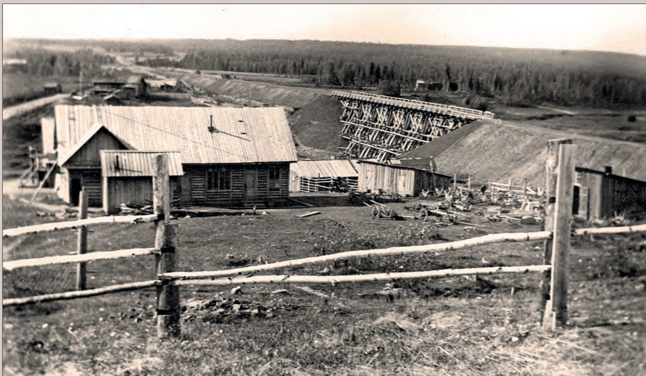
Мост на строящейся железной дороге Пинюг – Сыктывкар за селом Вьльгорт. Из фондов Национального музея РК.
